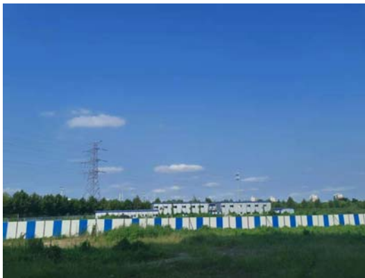
厂区东侧空地
